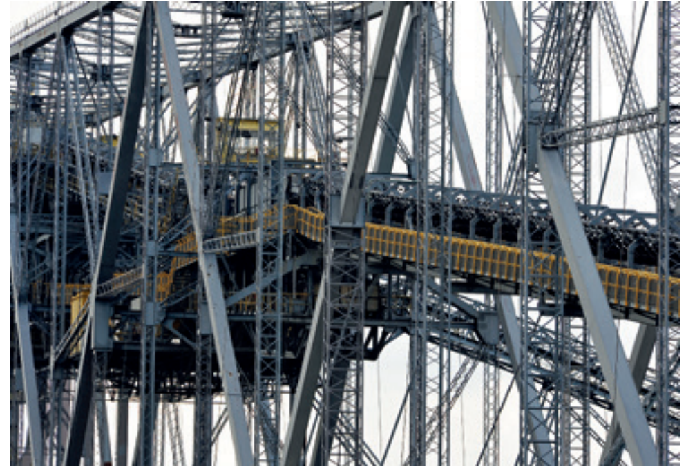
Die Trägerstruktur der Abraumförderbrücke F60
